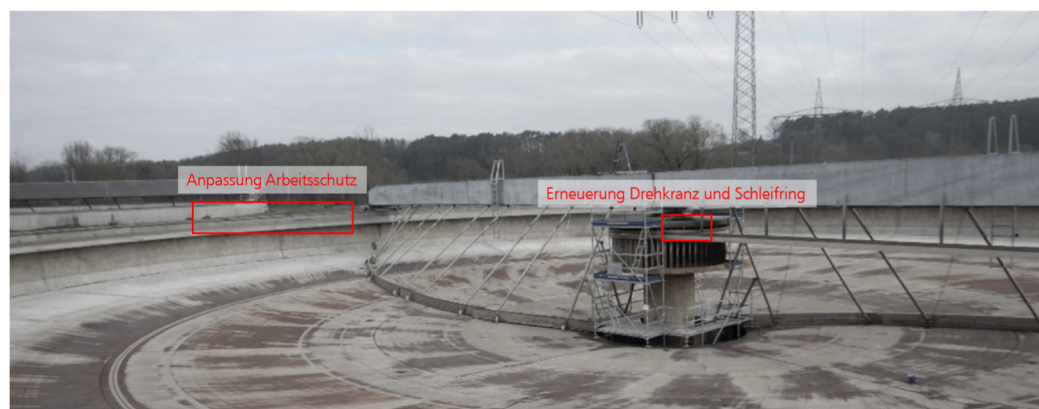
Abbildung 16: schematische Darstellung der erforderlichen Erneuerung an den Räubern
